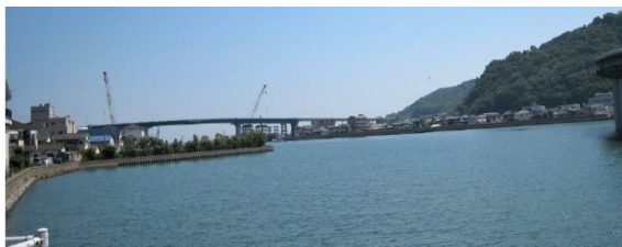
（仮称）第二天草瀬戸大橋連結した瞬間（左下島、右上島）
