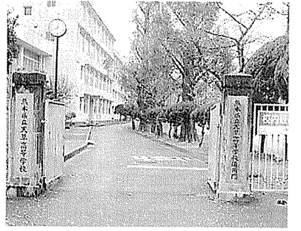
改修前の天神通用門
